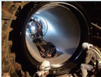
犬山系導水路A管の更新工事
